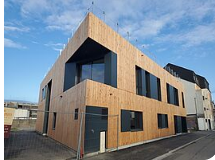
L'entreprise a construit un nouveau bâtiment afin d'accueillir son centre d'exploitation et de maintenance des parcs solaires et éoliens.
