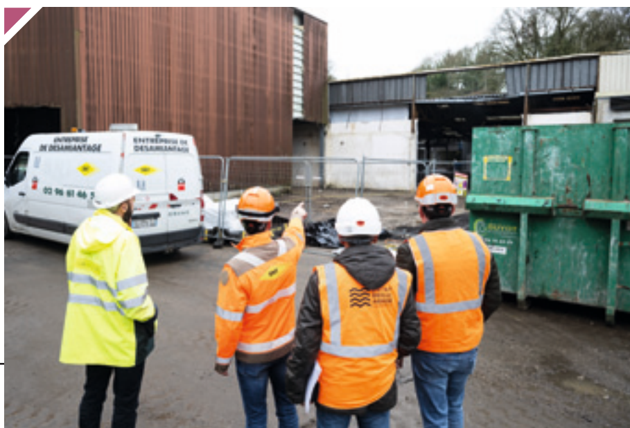
La déconstruction des bâtiments a démarré fin 2023.
