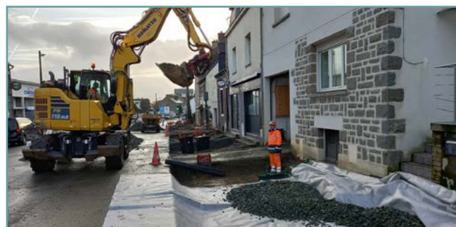
Mise en œuvre de la Gestion Intégrée des Eaux Pluviales (GIEP) dans le cadre du chantier TEO - Boulevard de l'Atlantique.
