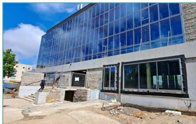
Futur Totem de l'Innovation en travaux, première opération de réemploi sur le territoire. Ce projet de réhabilitation tertiaire réemploie 15 tonnes de matériaux in situ et ex-situ, dont presque 1/3 donnés lors de l'événement Le REMP'.
