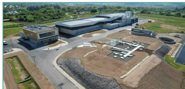
Nouvelle usine d'eau potable de la Croix Cholin.
