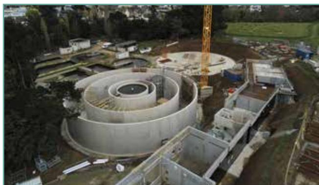
La station d'épuration de Saint-Quay-Portrieux va disposer d'un grand bassin circulaire intégrant plusieurs fonctions dans le traitement des eaux usées. Ce système permet de réduire les délais de construction, d'assurer une continuité de service optimale et de libérer du foncier pour des aménagements futurs.
