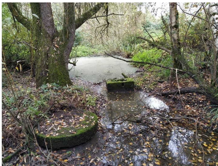
Figure 21. Photographie du réseau à proximité de l'affluent du Gouédic
