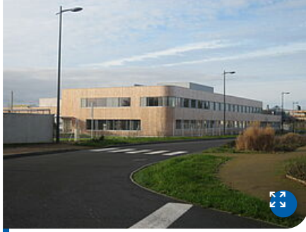
Le Centre Technique de l'Eau
