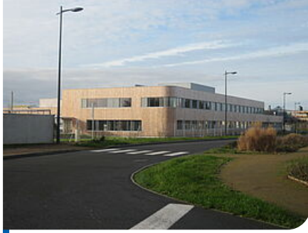
Le Centre Technique de l'Eau
