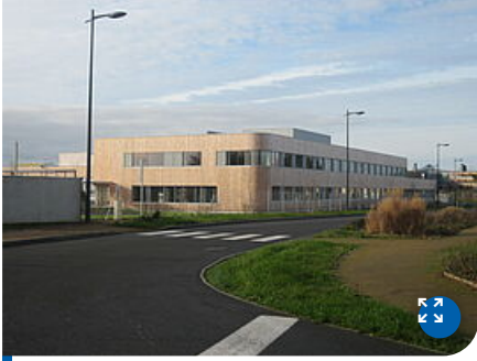
Le Centre Technique de l'Eau
